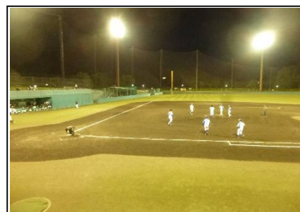
夜間照明設備
